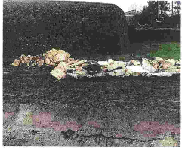
Materiali di risulta nel corso delle operazioni di ripristino
