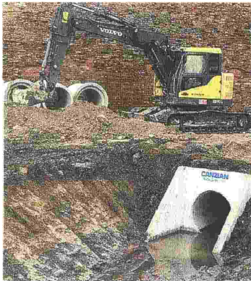
Una ruspa al lavoro per gli scavi
