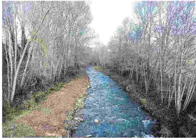
Torrente Archiano Dopo i lavori del Consorzio di Bonifica
