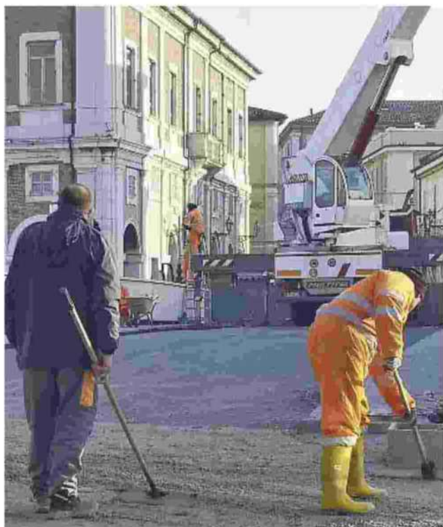
Gli ultimi ritocchi al ponte 2 Giugno in attesa delle prove di carico e poi dell'apertura
