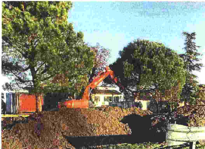
CANTIERE APERTO Lavori sulla strada provinciale 45 a Meolo a cura della Città Metropolitana con il Consorzio di Bonifica Piave
