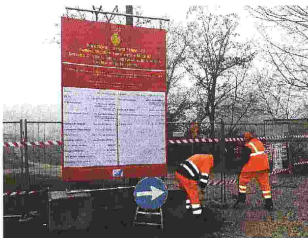
CANTIERE II via ai lavori per la pista a Forte Bazzera
