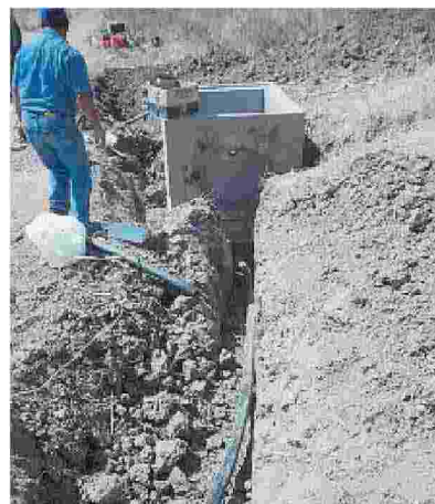
Sono stati avviati i lavori per la realizzazione di un acquedotto rurale per approvvigionare le zone agricole e le aziende zootecniche
