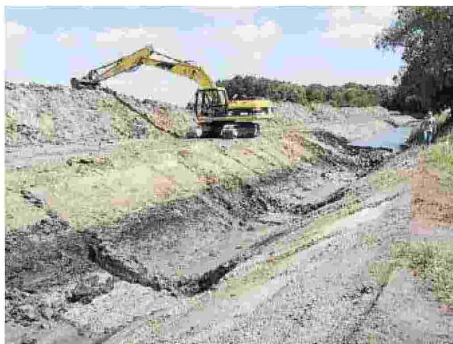
Un'immagine dello scavo del canale
