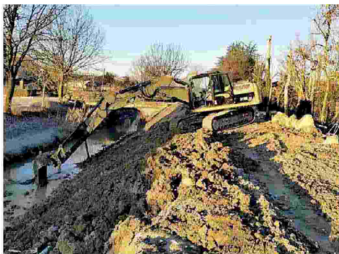
I lavori lungo la strada che collega Monticelli a Villanova e Castelvetro
