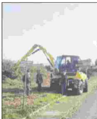
Gli interventi attuati
