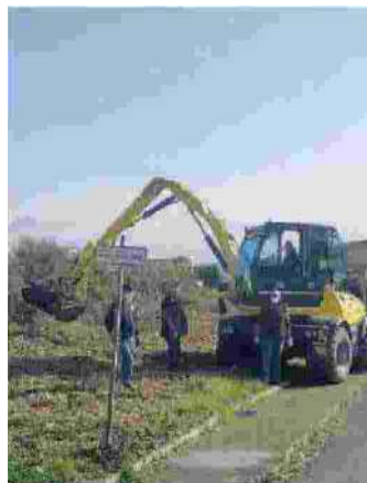
Ruspe al lavoro Interventi di pulitura della vegetazione
