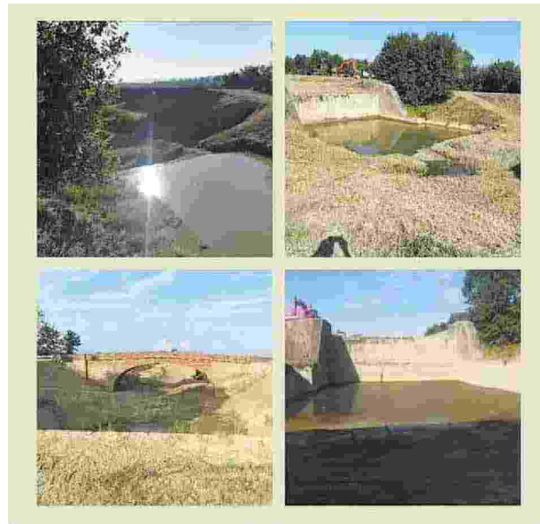
Lavori Consorzio di Bonifica, 2020 positivo. Un'opera sul versante senese
