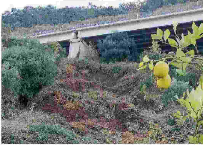
Dissesto idrogeologico Il movimento franoso ha un fronte di 25 metri
