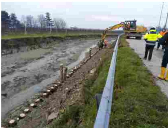
Anche l'intervento di ripresa frane lungo la via Faccini a lato del canale Collettore Acque Alte, per una lunghezza complessiva di circa 226 metri, ha raggiunto un buono stato di avanzamento e a breve sarà concluso.
