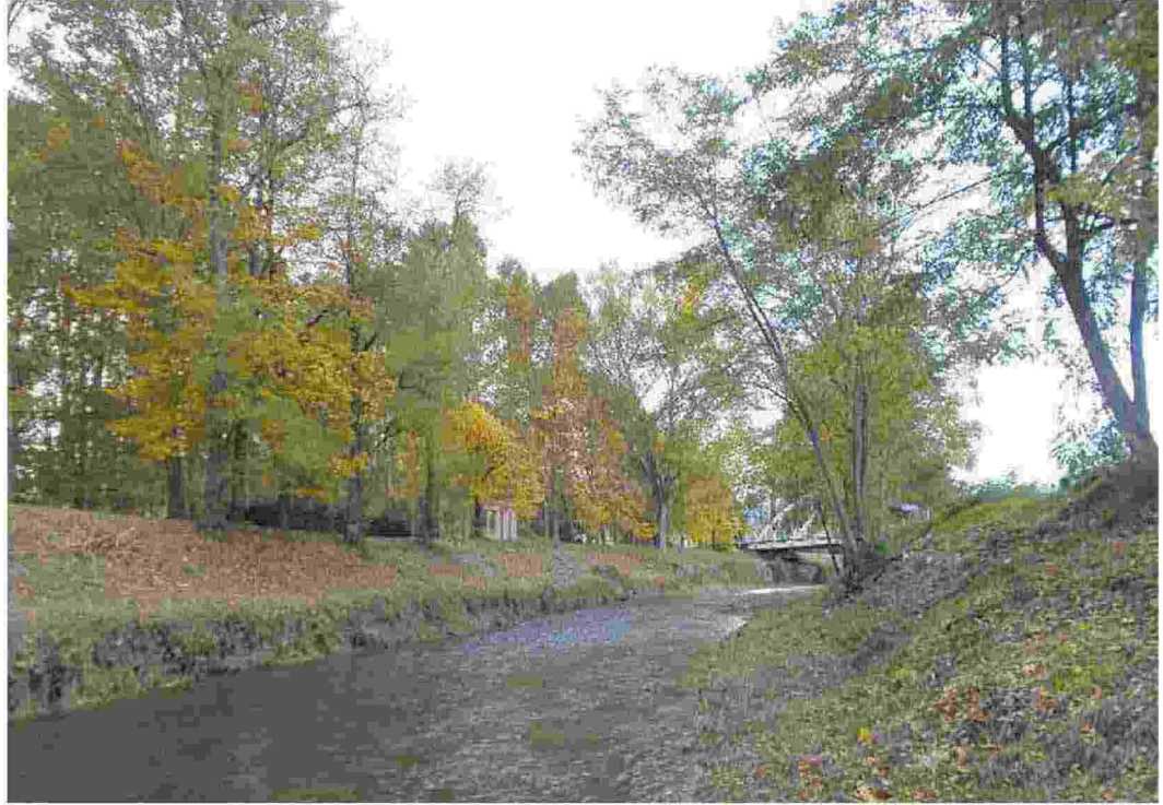
Interventi del Consorzio sul verde Per migliorare il defluire dell'acqua ed evitare problemi in caso di maltempo
