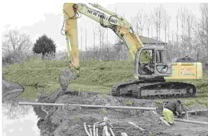
Cantiere aperto in Valle Giralda dove gli operai della Bonifica sono al lavoro
