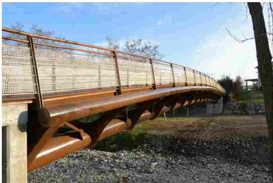
Il nuovo ponte, costruito in legno e poggiato su una struttura tubolare in metallo da 43 tonnellate
