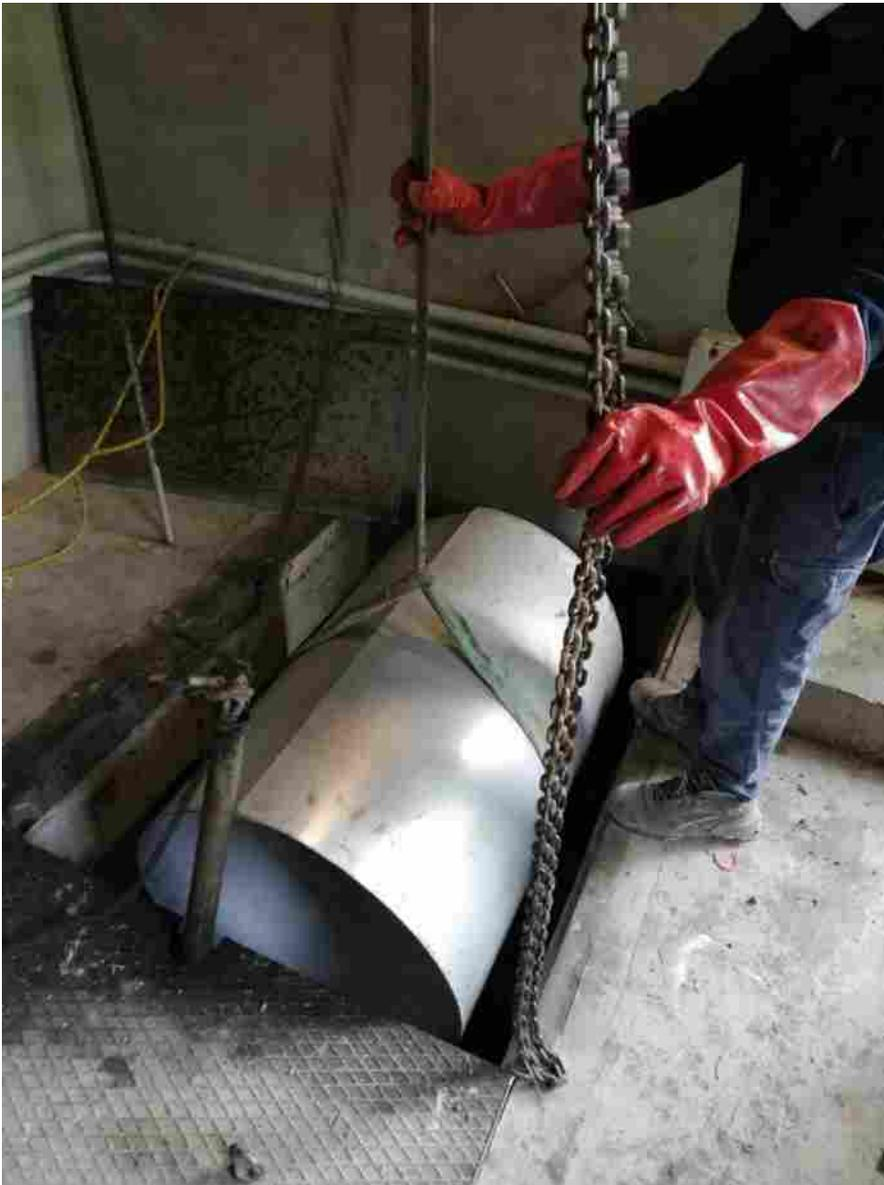
SAN BENEDETTO – Intervento del Consorzio di Bonifica Terre dei Gonzaga in Destra Po a San Benedetto in strada Pigozza all’impianto denominato “Zanolo”: il tubo di mandata, completamente corrosivo, è stato recuperato infilando un nuovo tubo in acciaio inox all’interno dell’esistente. Successivamente è stato saldato alla flangia esistente, ed infine verniciato per garantirne la lunga durata.
