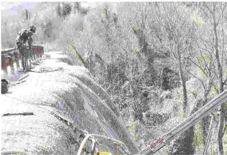
Gli operai sulla strada consorziale sono al lavoro dal 17 febbraio scorso. Per l'occasione la Regione ha stanziato 40mila euro
