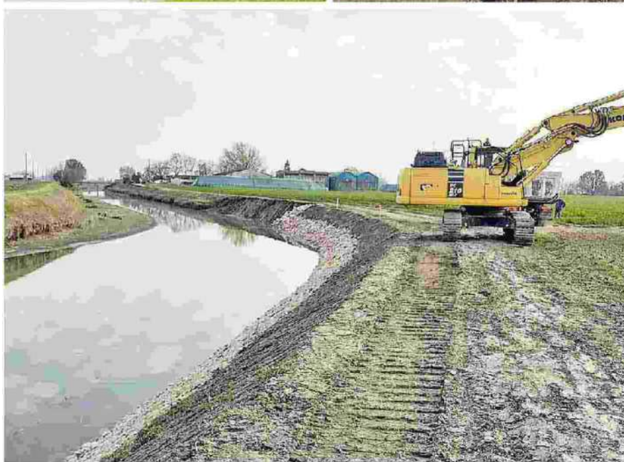
In alto a sinistra, la messa in sicurezza del canale Sabbioncello dopo la frana del maggio 2020 A destra e sotto, i lavori di sistemazione del canale compiuti in queste ultime settimane
