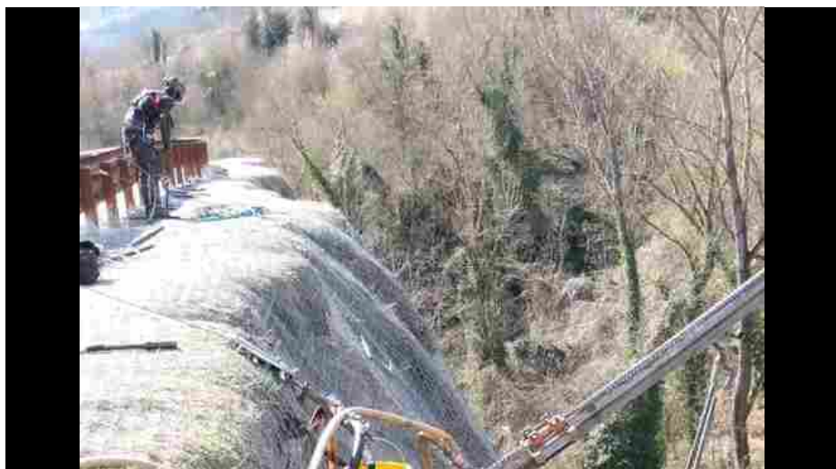
Gli operai sulla strada consorziale sono al lavoro dal 17 febbraio scorso Per l'occasione la Regione ha stanziato 40mila euro
