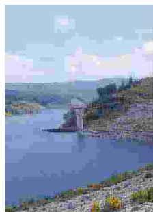
Galatro Uno scorcio della diga in contrada Castagnara
