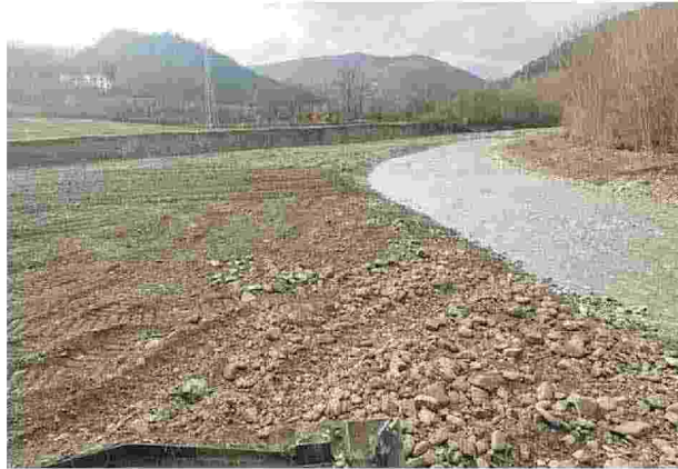
Ambiente e sicurezza Lavori idraulici del Consorzio di Bonifica
