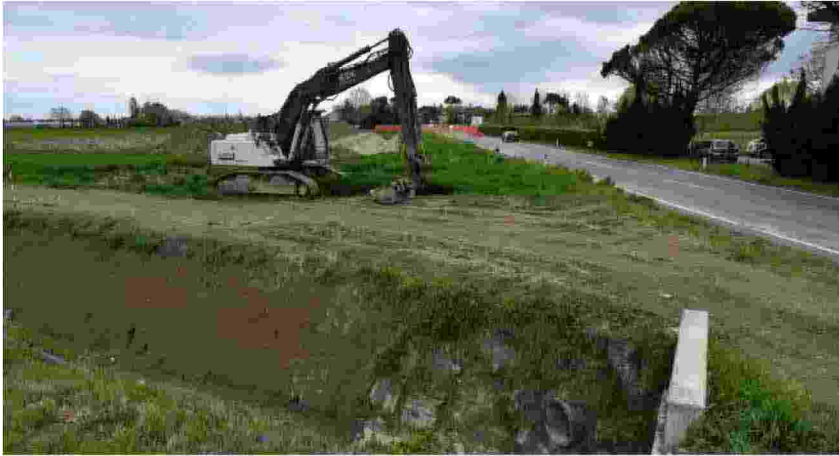
Macchinari al lavoro sulla strada Cervese tra Bagnolo e Carpinello FOTO FABIO BLACO
