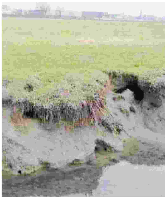
Un tunnel scavato dalle nutrie lungo l'argine di un canale
