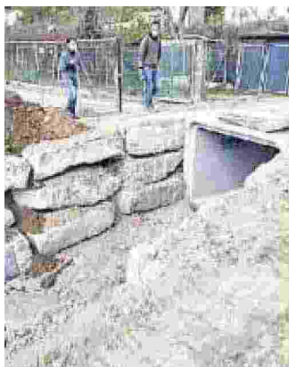
I lavori in corso del Consorzio
