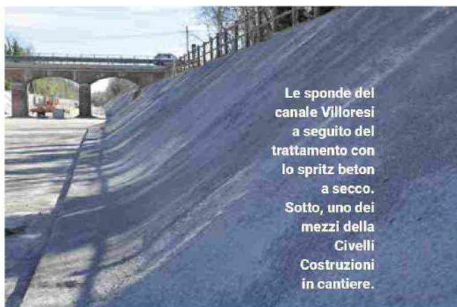
Le sponde del canale Villoresi a seguito del trattamento con lo spritz beton a secco. Sotto, uno dei mezzi della Civelli Costruzioni in cantiere.
