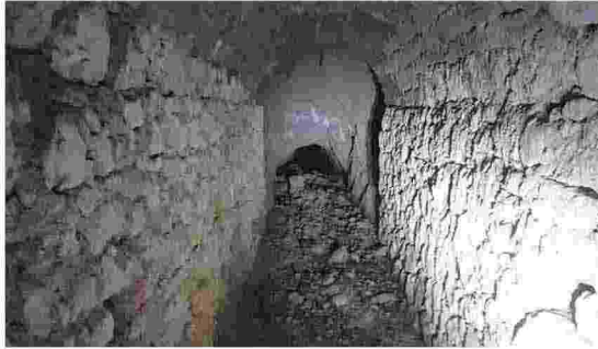
Il cunicolo Sopralluogo con ispezione ad Abbadia Isola nel comune di Monteriggioni
