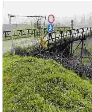
Il ponte Locarolo a Bozzolo
