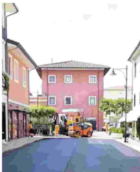
Uno dei cantieri che sono in centro
