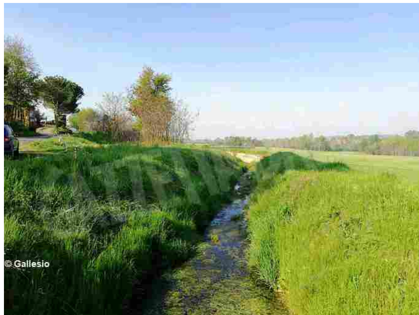
Un tratto del rio Corva, ramificazione terminale delle infrastrutture del consorzio Bealera maestra.
