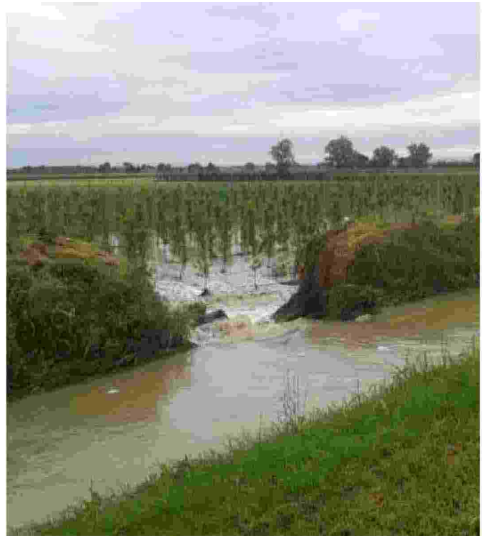
Una delle rotture dell'argine del Canale dei Mulini
