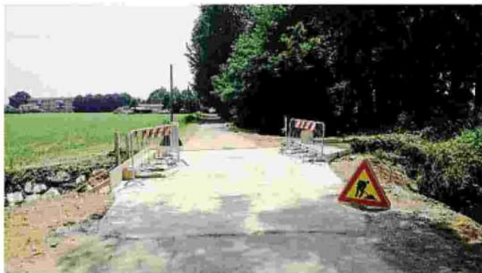
Il nuovo tratto di asfalto sulla ciclabile dove si era formata una voragine
