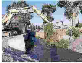
Ruspe in azione Partiti i lavori per la pulizia dei fossi di scolo
