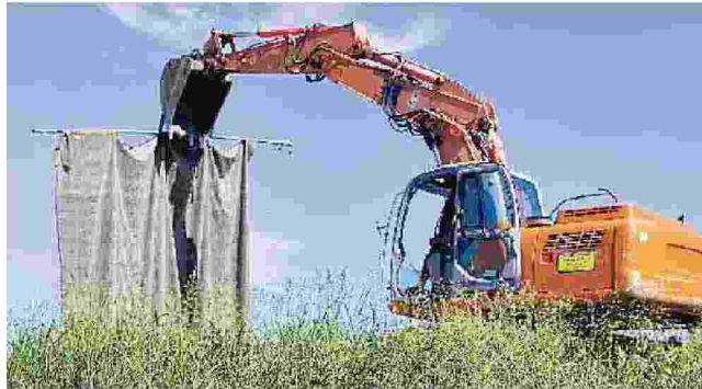
I lavori di ripristino del consorzio di bonifica
