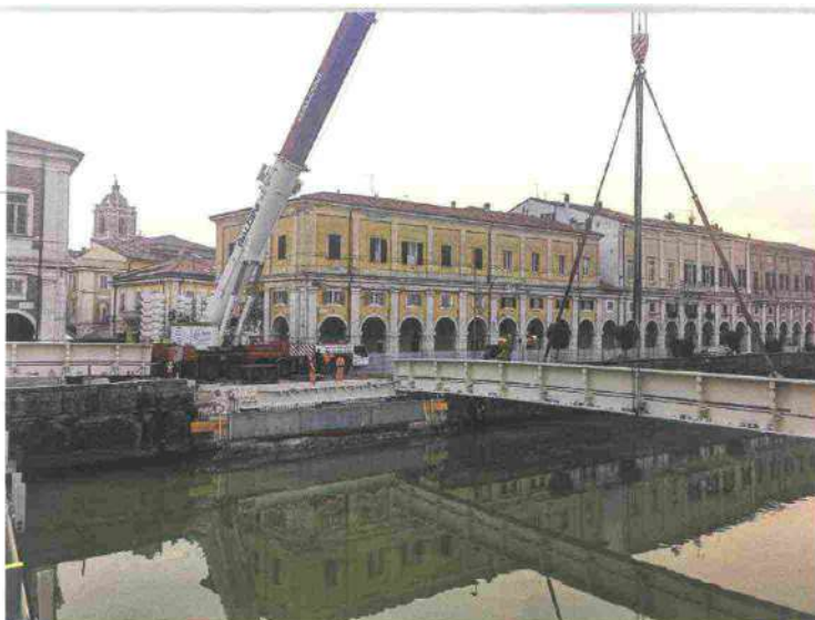
8. Il sollevamento e la posa in opera della prima trave il 17 Dicembre 2020
