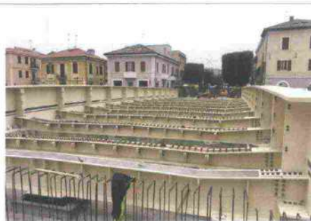
9. Il completamento del montaggio dell'orditura costituita da travi e traversi
