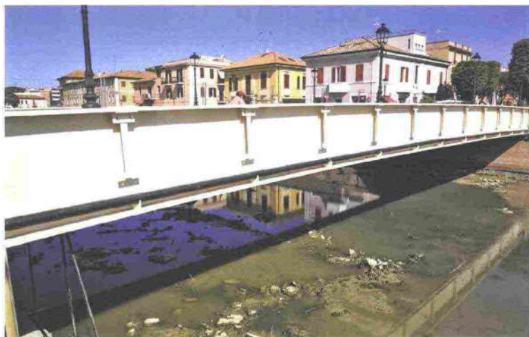
7. La predisposizione di montanti metallici per il successivo fissaggio dei pannelli esterni di rivestimento
