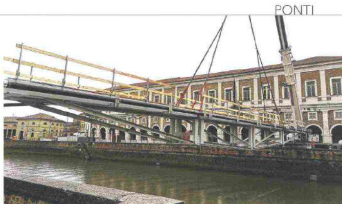
3. La posa in opera, tramite autogrù, della passerella provvisoria per l'alloggiamento delle tubazioni il 15 Ottobre 2020, all'inizio dei lavori
