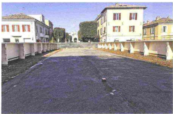
10. Il getto di prima fase della soletta, a meno dei cordoli, già transitabile in data 31 Dicembre 2020
