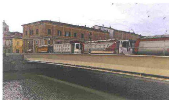
11. Il collaudo statico dell'opera, tramite otto autocarri da 40 t
