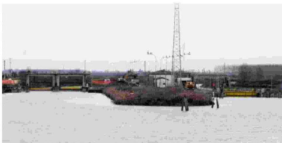
Banchina fluviale sull'idrovia Fissero-Tartaro-Canalbianco a Torretta di Legnago
