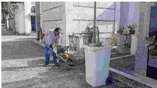
Al lavoro Un operaio impegnato nelle operazioni di bonifica
