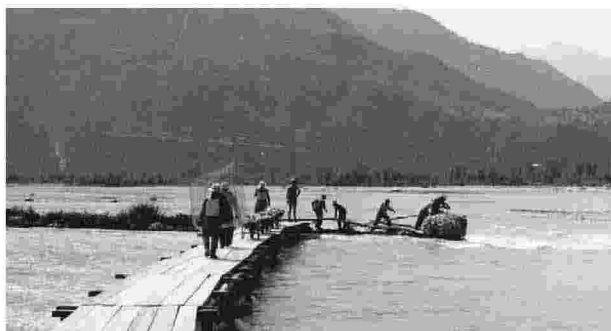
Opere di riparazione dell'alveo del Tagliamento presso Ospedaletto (archivio Consorzio di Bonifica Pianura Friulana).
