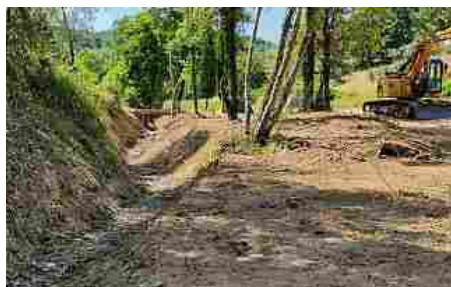
Il Borro di Cappiano dopo la conclusione dei lavori
