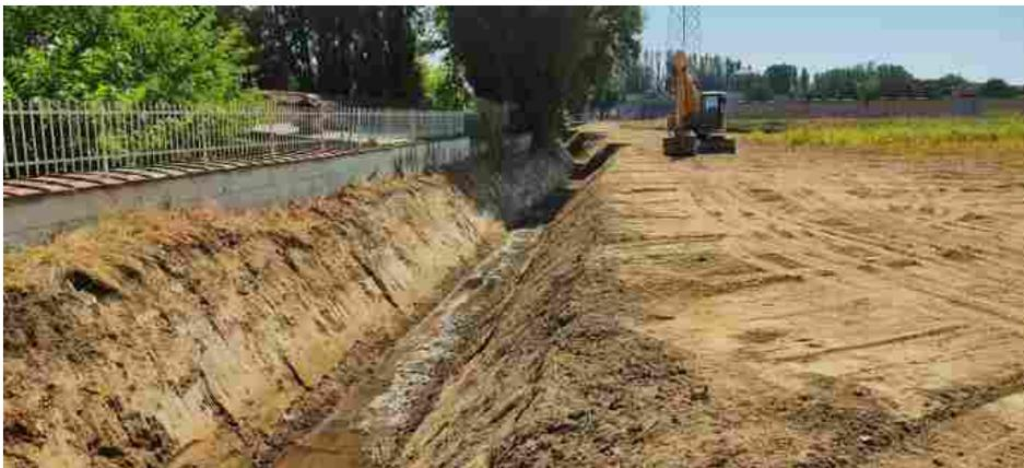
Via i sedimenti nei corsi d'acqua per la sicurezza idraulica. Gli operai del Consorzio di Bonifica proseguono i lavori in Valdarno, con interventi sul torrente Forestello e sul borro della Quercia. In programma a breve una analoga operazione sul Borro della Madonna a San Giovanni. I sedimenti recuperati serviranno per rimodellare i corsi d'acqua o per ripristinare le erosioni in Arno. L'obiettivo è duplice: evitare rifiuti costosi da smaltire e irrobustire il reticolo
