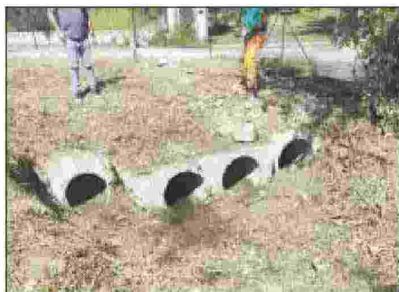
Uno dei canali oggetto di pulizia
