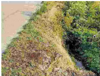
Manutenzione lungo i canali di scolo, l'associazione interviene
