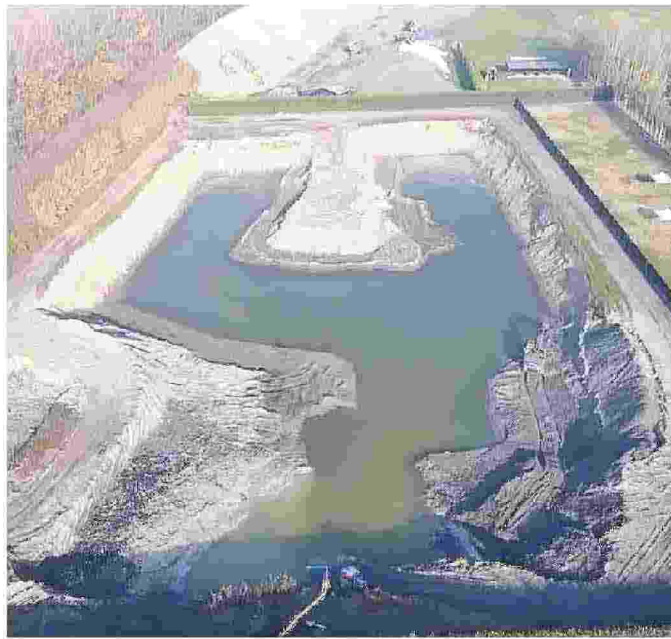
L'area di scavo del laghetto al centro Le Tre Piume
