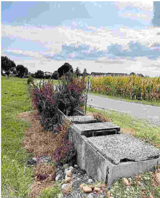
Le canalette del sistema irriguo
