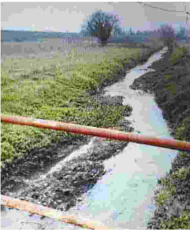
Reglia dei mulini Lavori sull'alveo
