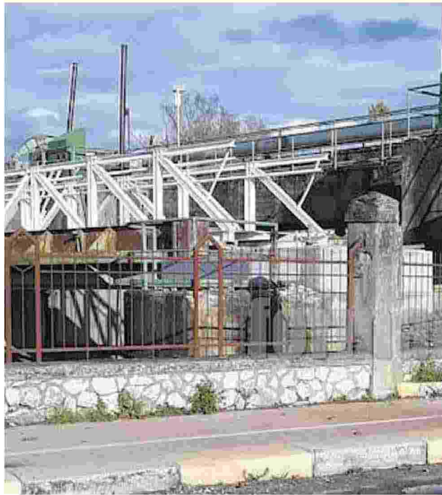
Passerella pedonale L'opera che attraversa le chiuse sul fiume Velino sulla Giorlandina era ferma da diversi mesi per la mancanza dei materiali
