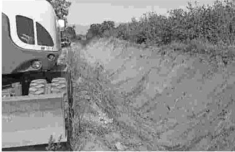
Uno scatto di un escavatrice in azione nella località Martiniello
