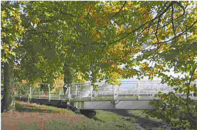
Il Ciuffenna Lavori sulle sponde e sugli alvei anche sugli affluenti per la sicurezza.
