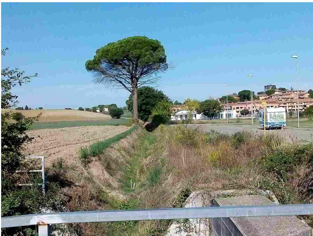
Consorzio di Bonifica 6 Toscana Sud impegnato nella messa in sicurezza dell'abitato di Monteroni d'Arbia attraverso la manutenzione del reticolo idrografico minore. I lavori di manutenzione ordinaria di alcuni corsi d'acqua che scorrono in questa zona sono finalizzati al ripristino dell'efficienza idraulica e al regolare scorrimento delle acque verso valle: interventi sul fosso Felicaio, sul fosso della Rotatoria, sul fosso della Riombuta e sul fosso della Croce.
