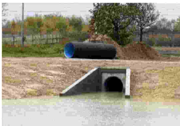
Vasca di laminazione in costruzione a Villaggio Trieste di Cerea ENNE FOTO
