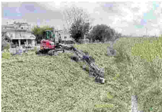
I lavori per la pulizia del fosso Cannelacci
