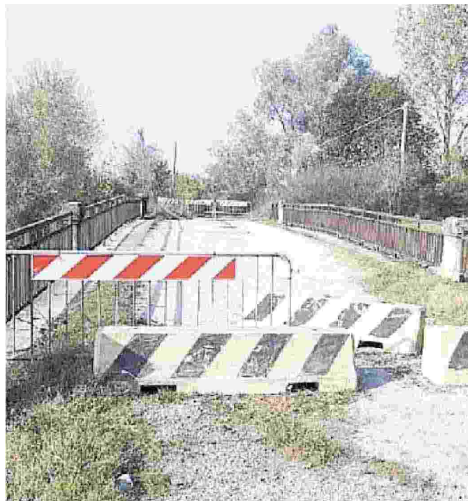
Le transenne che sbarrano il ponte tra Moglia e Rolo
