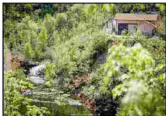
Centrale idroelettrica di Roasio (VC)
