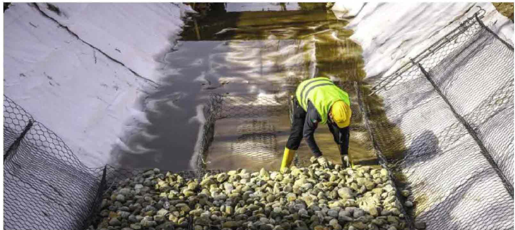
L'opera di ripristino e impermeabilizzazione della Roggia di Lenta (VC)
