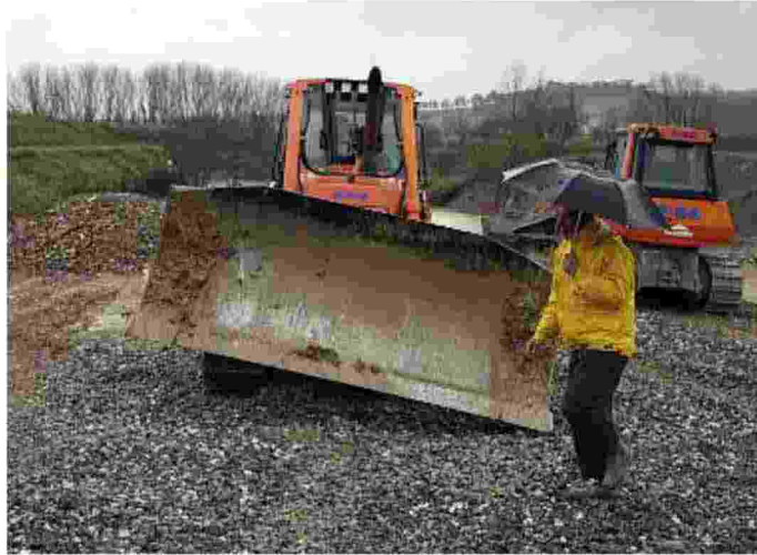
Alcuni operai impegnati nei lavori di messa in sicurezza lungo un argine
