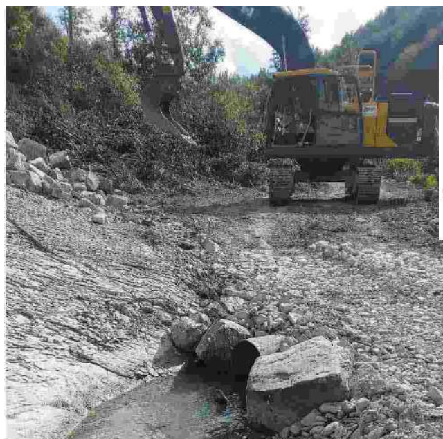
Lavori Il Consorzio di Bonifica al lavoro sul fiume Marecchia che nasce nel comune di Badia Tedalda
