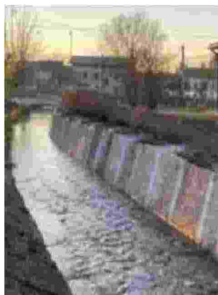
Il Volon I lavori in via Cavour
