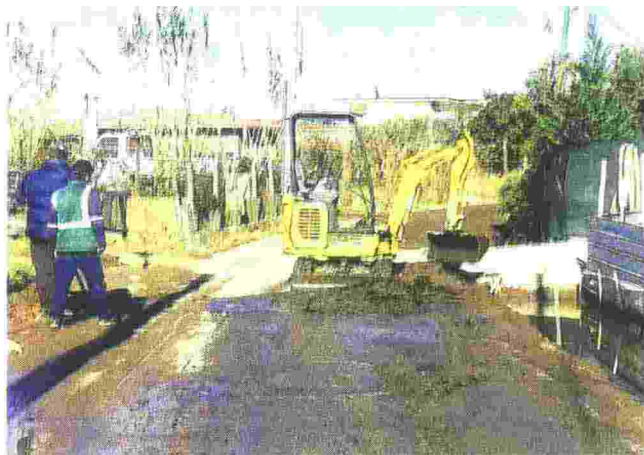
I lavori di pulizia del canale in via Longole
