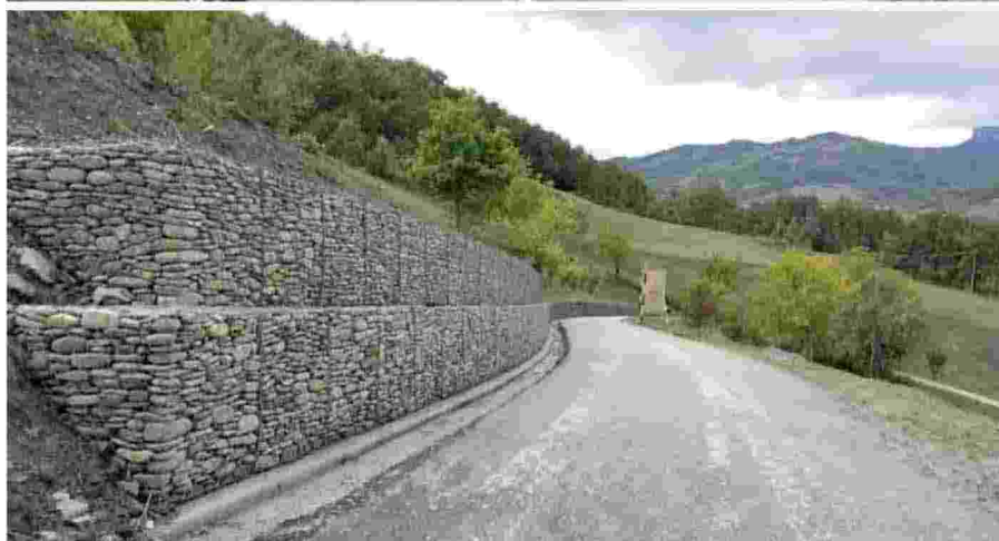
Un consolidamento in zona Salvarana - Ca' del Vento; sopra interventi anti-dissesto a L'Oca e Vogno
