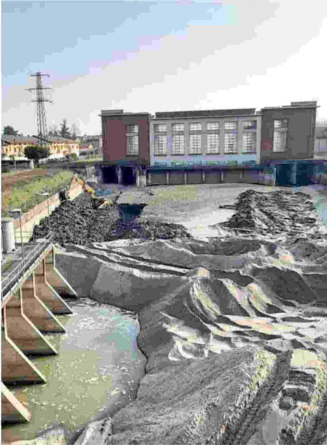
La sabbia accumulatasi al nodo idraulico di Boretto
