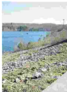
Diga sul Metramo. Da anni se ne attende un reale utilizzo
