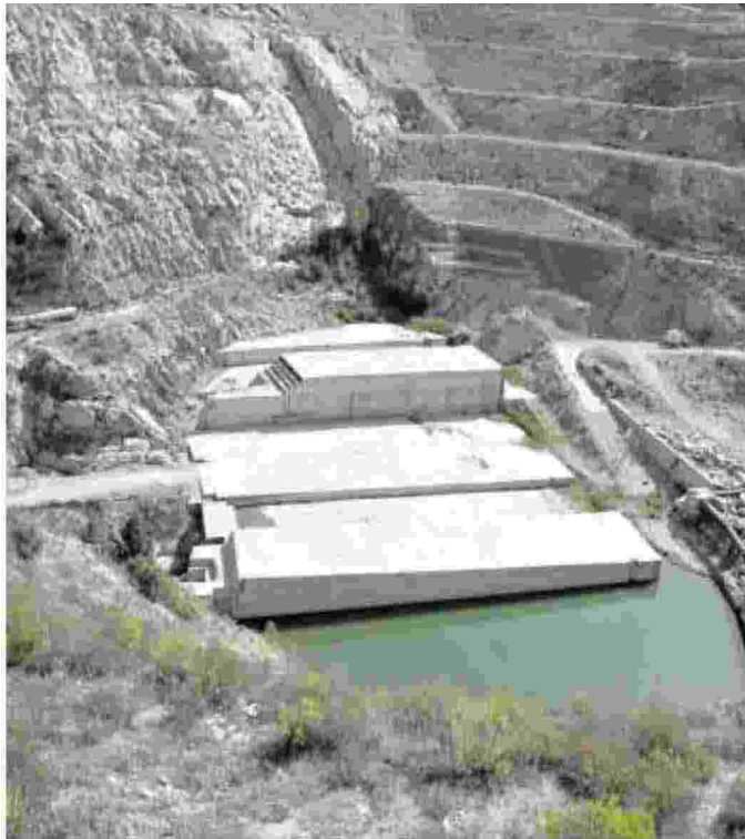
Il cantiere alla diga di Cumbidanovu
