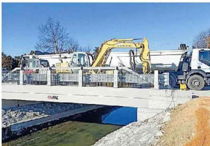
Le prove di carico eseguite ieri sul ponte del torrente Ghebo
