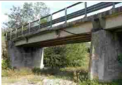
A seguito delle criticità ad alto rischio emerse dall'ispezione annuale dei ponti comunali, il servizio Progettazione ha realizzato uno studio di fattibilità tecnica ed economica di un intervento in grado di garantire la stabilità idraulica e statica del manufatto, in relazione alle piene del torrente Tesino. Nel tempo, infatti, tale fenomeno ha deteriorato gli elementi portanti della struttura, come meglio specificato nella relazione in allegato, firmata dall'arch. Bernardino Novelli.
