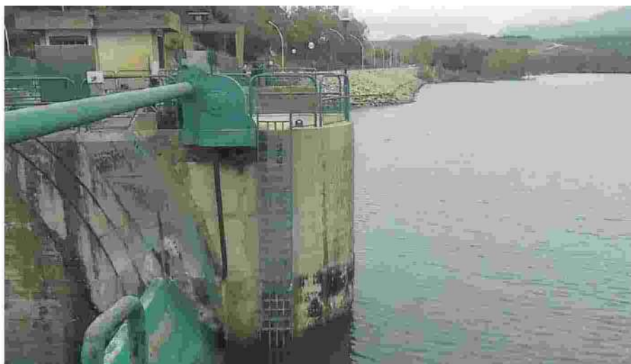
Partinico. Uno scorcio della diga e del bacino dello Jato
