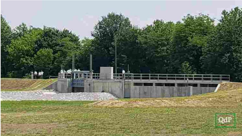
Il cantiere ha così realizzato due casse di espansione, oltre alla ricostruzione del ponte sul Codolo (in funzione oramai da gennaio), in via XXX Ottobre a Codognè: l'opera serve a regolare la piena, per evitare allagamenti, mentre un sistema automatizzato tiene sotto controllo la situazione, con l'entrata in funzione delle paratoie, di fronte a un livello d'acqua allarmante.
