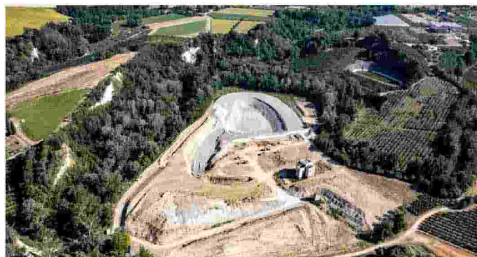
I lavori al bacino Moreda
