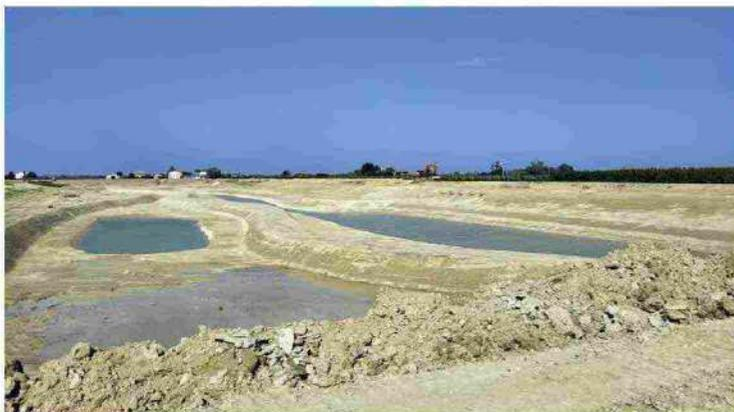
6,5 ettari, per un importo complessivo di 3,3 milioni di euro di lavori. L'altezza utile dell'invaso è di 3,2 metri. Sono inoltre previsti: il ris sezionamento dello scolo Rivalone, la realizzazione di un manufatto di regolazione, di uno sfioratore in destra idraulica del Rivalone, di
