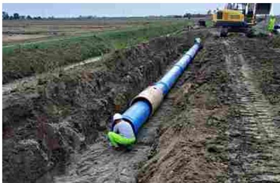
Nei Comuni di Copparo e Riva del Po è terminata la posa di nuova tubazione idrica di collegamento a quelle esistenti, nelle località di Copparo in via Guarda e Guarda Ferrarese in via Copparo.
